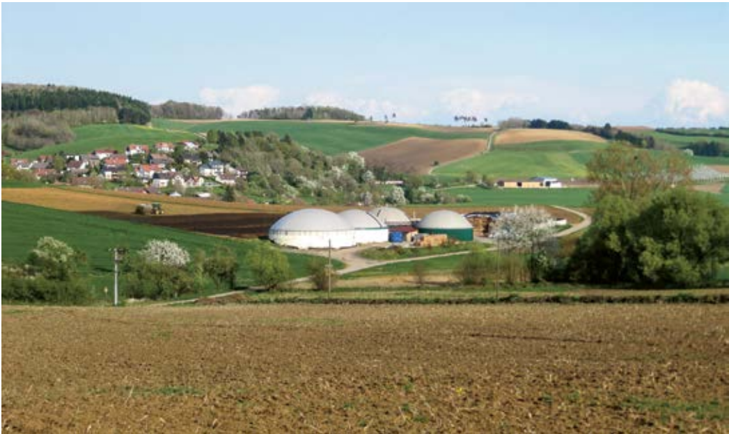
Abbildung 2: Ein grundlegendes Problem bei Biogasanlagen ist die nach wie vor völlig unzureichende Nutzung der Abwärme, welche an die Umgebung abgegeben wird. Diese macht immerhin 50–60 % der erzeugten Energie in einer Biogasanlage aus. Foto: Rainer Luick
