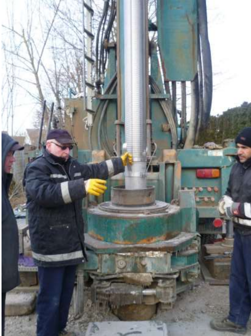
Abbildung 1: Einbau des Schlitzrohrfilters im Injektionsbrunnen im Anstrombereich des Aquadroms.
